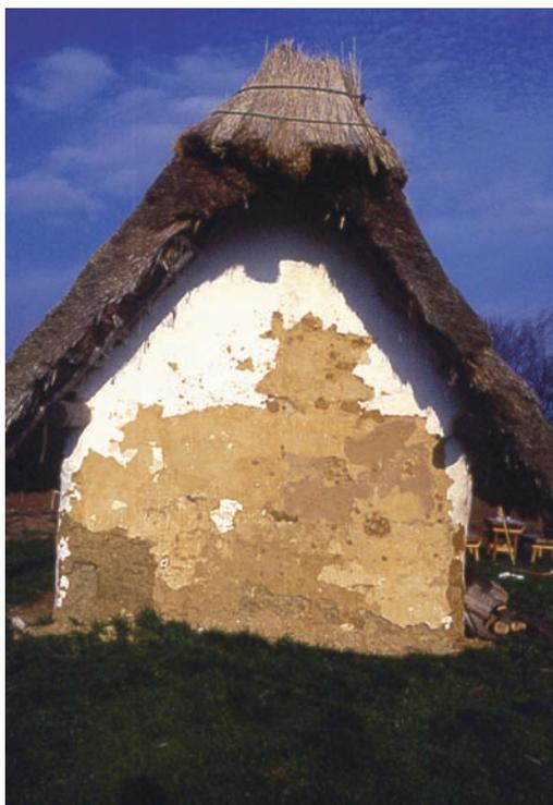
Abb. 25: Abgeplatzte Tünche und freiliegender aufgewitterter Lehmverputz an der Westseite des Hauses im April 1999. Foto: J. P. Zeitler.
