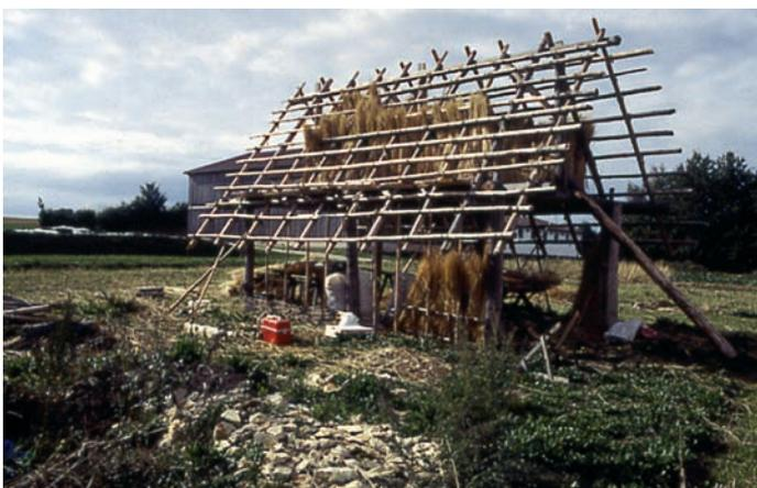
Abb. 9: Der Holzrohbau des Hauses mit Rofen und Dachlattung. Foto: J. P. Zeitler.
