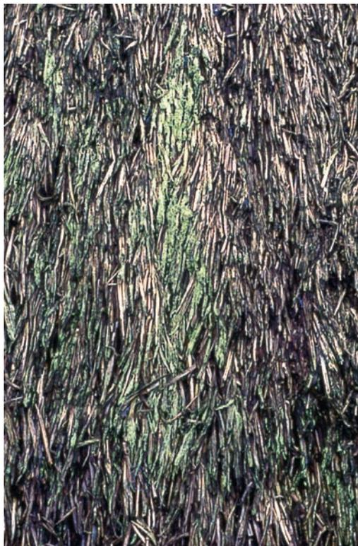
Abb. 23: Moosüberwachsene Stellen im Dach an der Nordseite. Foto: J. P. Zeitler.
