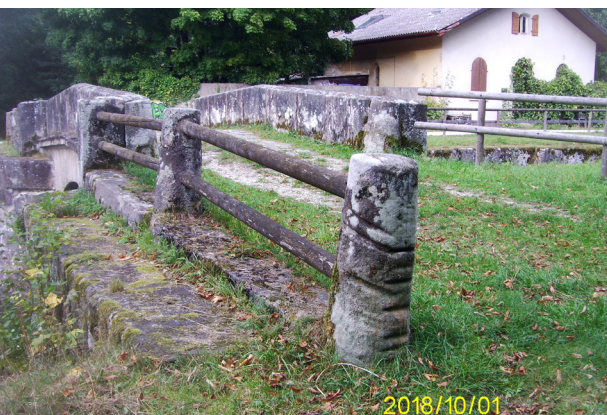
Abb. 5: Die Riefen an den Pollern sind Schleifspuren vom Treidelseil; hier an Schleuse 49.
