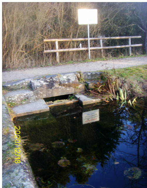
Abb. 148: Überlauf zum Durchlaß des Ottergrabens an Schleuse 70
