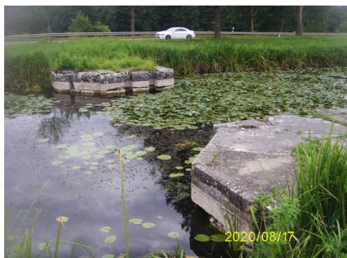
Abb. 65: Sicherheitstor-Fundament bei Rappersdorf. Der helle Streifen markiert den abgesenkten Wasserstand infolge eines Lecks bei der oberhalb liegenden Schleuse 26.
