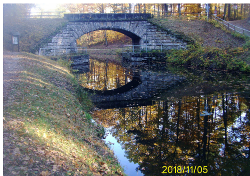
Abb. 11: Die Sorger Kanalbrücke vereinigt die Eigenschaften von Bogen- und Roßbrücke.
