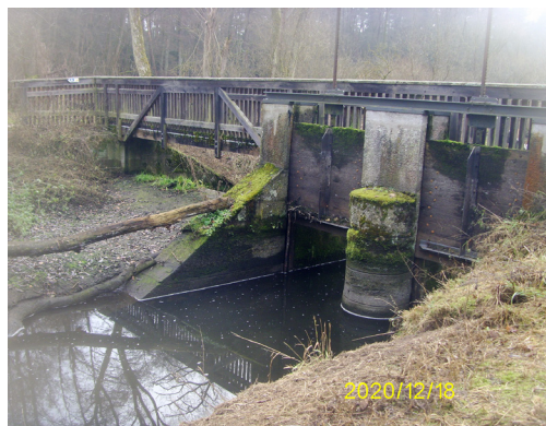
Abb. 139: Wehr im Gauchsbach zur Speisung des Leitgrabens
