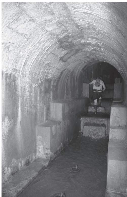
Abb. 113: Innenausbau des Tiefenbach-Durchlasses
