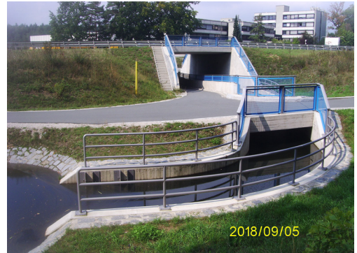
Abb. 79: Verlegung des Wasserlaufes infolge neuer Straßenbauten am Bögl-Gelände bei Schlierferhaide
