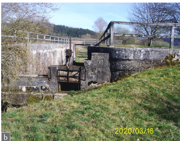
Abb. 50: a) Kammer und b) Oberhaupt der Schleuse 22 bei Beilngries
