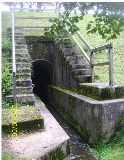
Abb. 102: Westportal des Gruberbach-Durchlasses, 2005 restauriert
