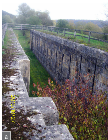
Abb. 50: a) Kammer und b) Oberhaupt der Schleuse 22 bei Beilngries
