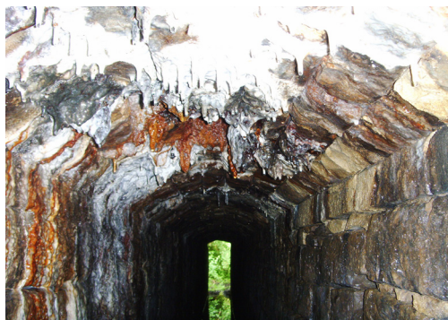
Abb. 17: Mineralisch eingefärbte Sinterbildungen in einem Entwässerungstollen
