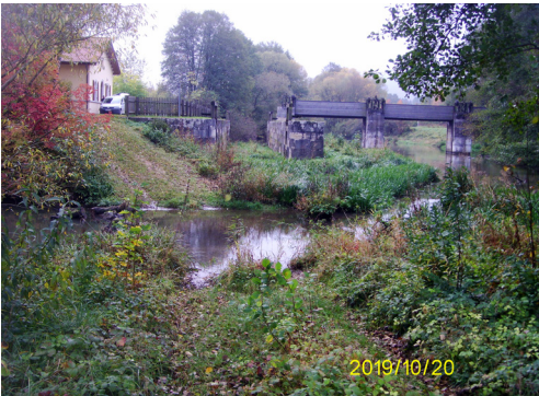
Abb. 38: Der Überrest von Schleuse 11. V.l.n.r. Wärrerhaus, Schleusenammer, Stauwehr
