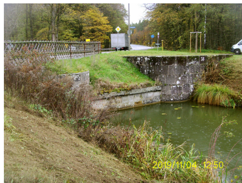
Abb. 119: Die Schleusenkammer 38 bei Pfeifferhütte ist am Unterhaupt mit der B8 überbaut.
