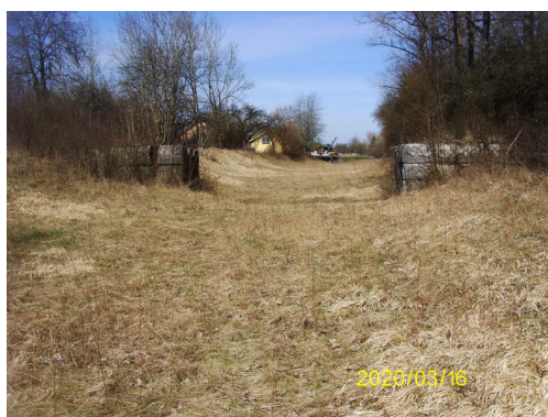
Abb. 54: Sicherheitstor-Fundamente vor dem Hafen Beilngries
