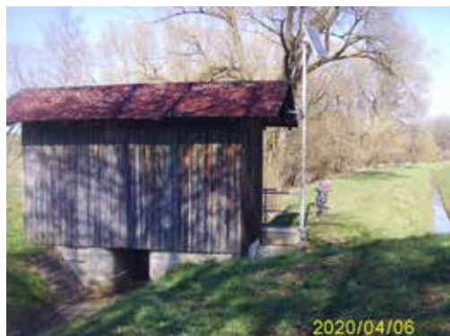
Abb. 103: Abzweiggebäude Schützenhaus des Hausheimer Leitgrabens in Hausheim. Links der Hausheimer Bach; nach rechts wird der Leitgraben abgeführt.
