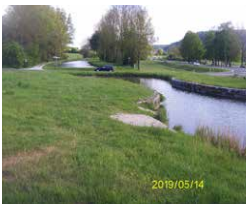
Abb. 60: Der Einzug der Kanalufer kennzeichnet den Standort der früheren Roßbrücke, die nun durch den Straßendamm nach Wallnsdorf im Hintergrund ersetzt ist. Blick kanalabwärts
