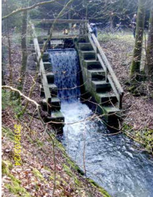
Abb. 20: Grundablaß bei Loderbach
