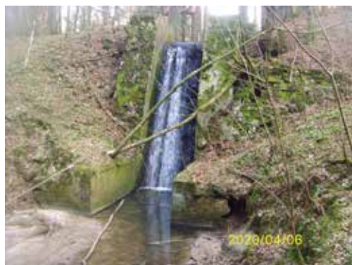
Abb. 114: Das Absturzbauwerk des Tiefenbachs
