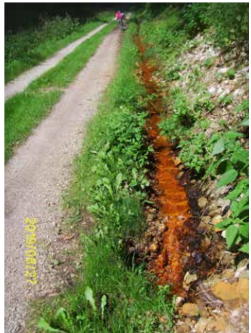
Abb. 89: Mineralische Ablagerungen aus dem Hang-Sickerwasser im Buchberger Einschnitt
