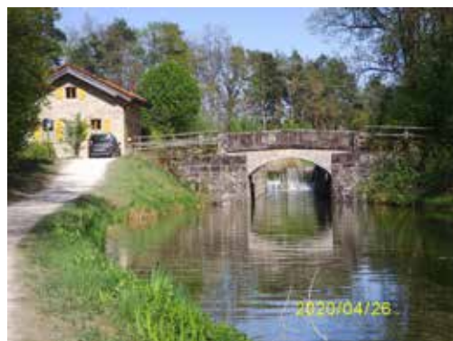
Abb. 118: Schleuse 37 mit der charakteristischen Bogenbrücke am Unterhaupt
