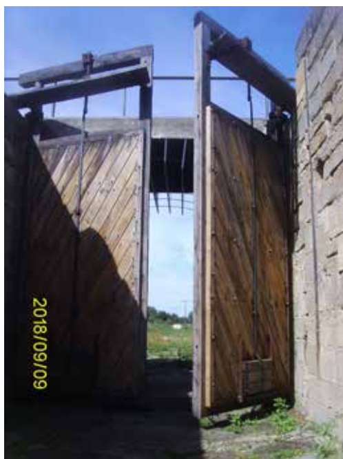
Abb. 180: Schleusentore am Unterhaupt der Schleuse 94
