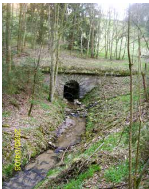
Abb. 112: Nordportal des Tiefenbach-Durchlasses mit dem hier 22m hohen Distellach-Damm im Hintergrund
