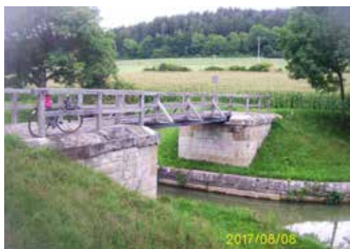
Abb. 10: Sogenannte „Roßbrücke“ mit hölzernem Oberbau und unten durchgeführten Treidelwegen
