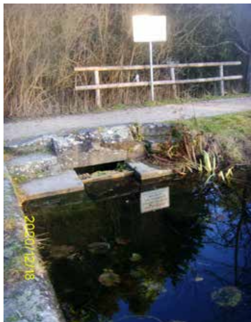
Abb. 148: Überlauf zum Durchlaß des Ottergrabens an Schleuse 70
