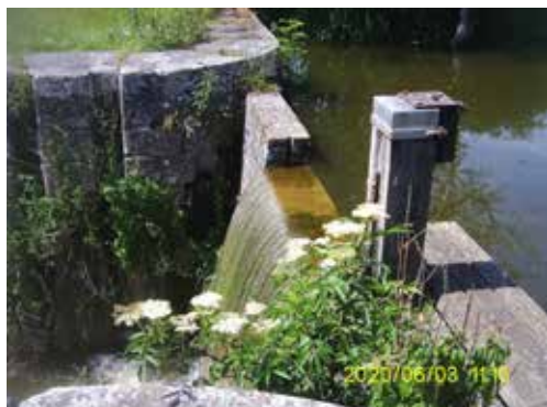
Abb. 45: Überfallmauer am Schleusenoberhaupt 14, mit dem Zahnstangenantrieb für ein Schütz
