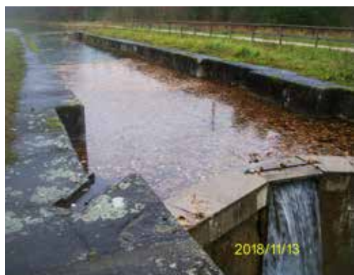
Abb. 125: Schleuse 57 mit gefüllter Schleusenammer
