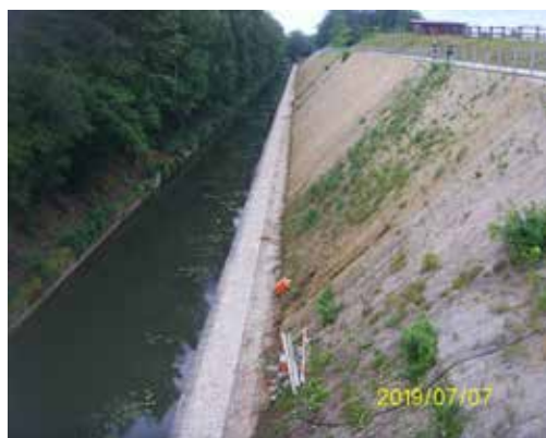
Abb. 110: Der sanierte Hang des Dörlbacher Einschnitts mit dem Radweg oben und dem wiederhergestellten Treidelweg unten
