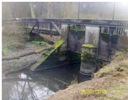
Abb. 139: Wehr im Gauchsbach zur Speisung des Leitgrabens
