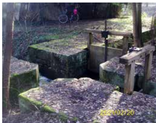
Abb. 149: Auslaßbauwerk des Ottergrabens (von links oben) bei Schleuse 70; rechts unten zum Leitgraben, oben zum Durchlaß
