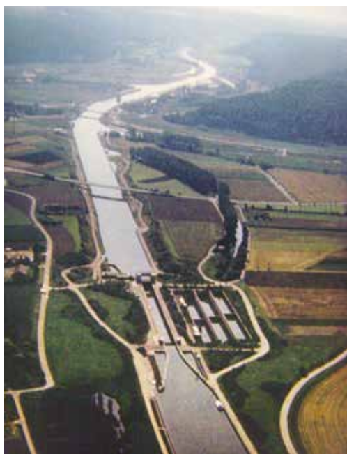
Abb. 43: Der MD-Kanal mit Schleuse Dietfurt, Blickrichtung Kelheim. Direkt oberhalb der rechts liegenden Sparbecken setzt der bogenförmig verlaufende Rest des Ludwigskanals an, mit Schleuse 14 am unteren Ende. Gegenüber vom oberen Ende liegt das Schleusenhaus 13. Foto: Rüfer 1993
