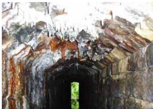
Abb. 17: Mineralisch eingefärbte Sinterbildungen in einem Entwässerungstollen
